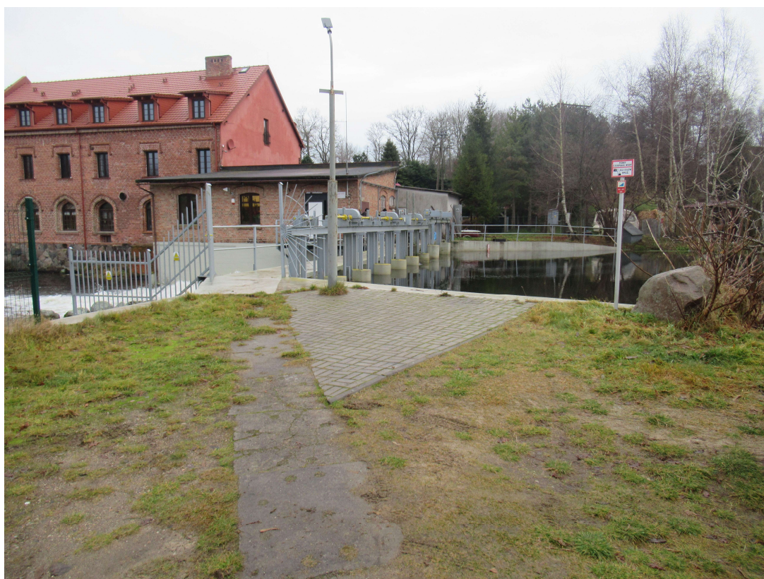
Fot.2 Widok na plac manewrowy - projektowane utwardzenie kostką betonową i montaż bierki wzdłuż lewobrzeżnego przyczółka jazu
